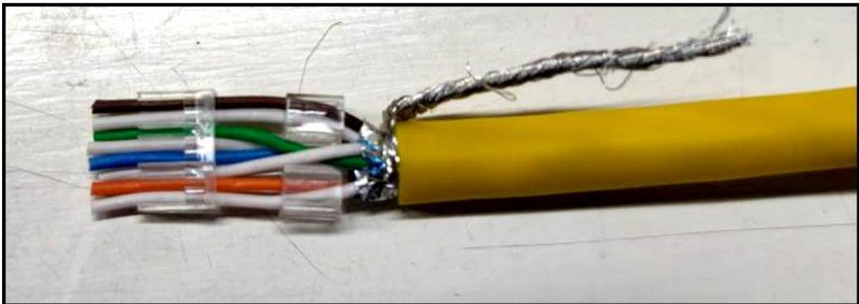
5. Die Adern entsprechend der T568B oder T568A Belegung in die Kabelführung B einlegen.
