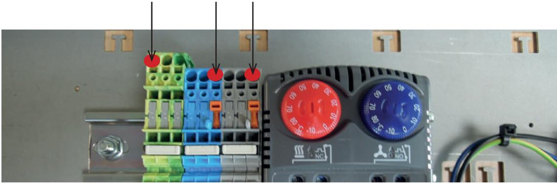
Schließen Sie die Kabel der Stromversorgung an die Klemmen der Stele an (Markierungen).
